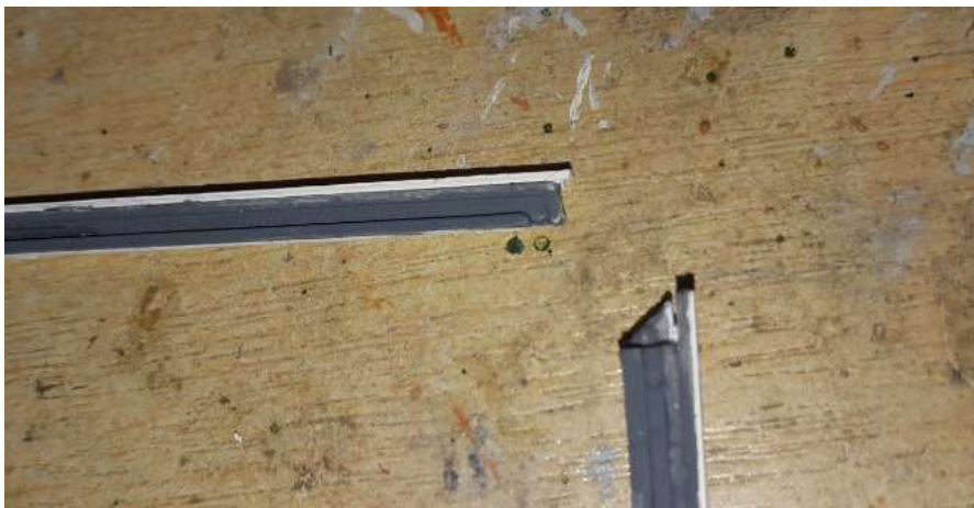
Detail hoekconstructie, vanaf de bovenzijde...
